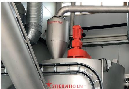
入口装有旋风分离器可提高洗砂机的处理能力。
