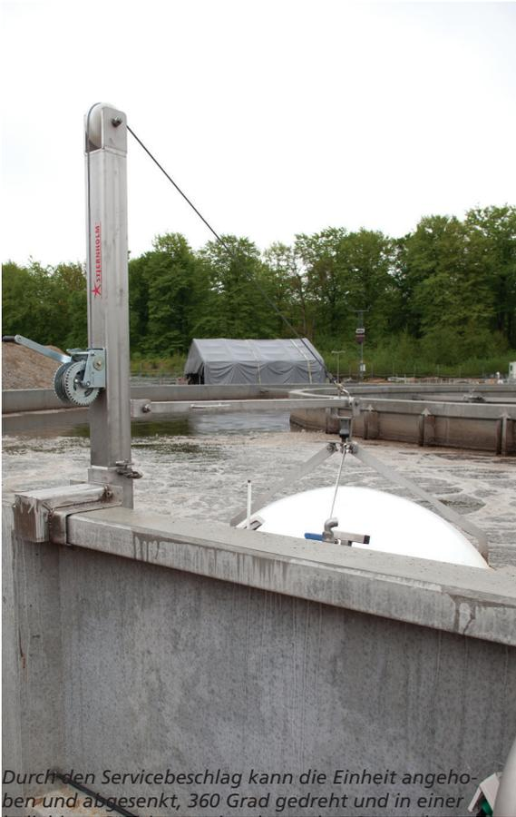
Durch den Servicebeschlag kann die Einheit angehoben und abgesenkt, 360 Grad gedreht und in einer beliebigen Position verriegelt werden. So werden Wartung und Inspektion erleichtert.
