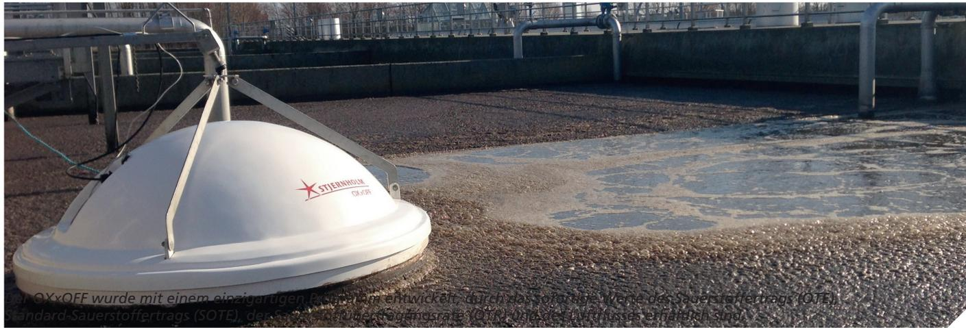
Der OXxOFF wurde mit einem einzigartigen Design entwickelt, durch das so hohe Werte des Sauerstoffertrags (OTE) bei Standard-Sauerstoffertrags (SOTE), dem Sauerstoffübergangskoeffizienten (OTR) und dem Durchfluss erreicht sind.
